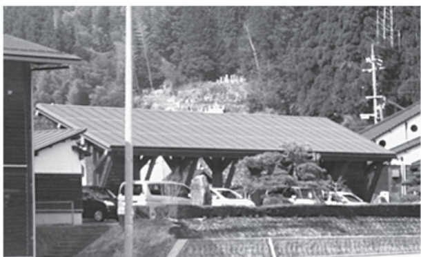
亀嵩小学校に設置されているソーラーパネル
